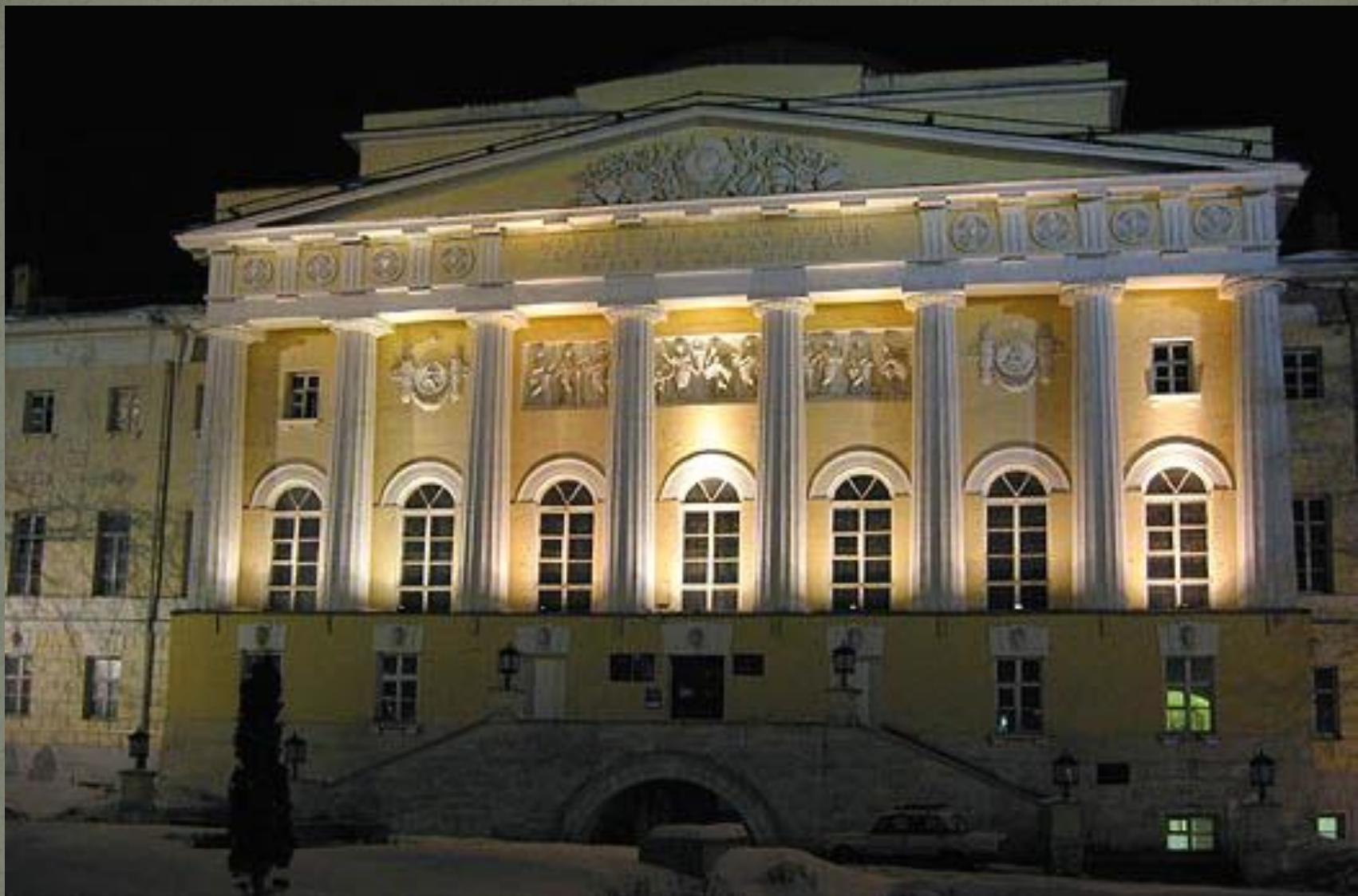
Д.Жилярди Здание МГУ
